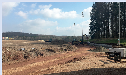
Hier entsteht die Tribüne.
