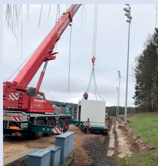
Der Technikraum für Beleuchtung und Beregnungsanlage wird angeliefert.
